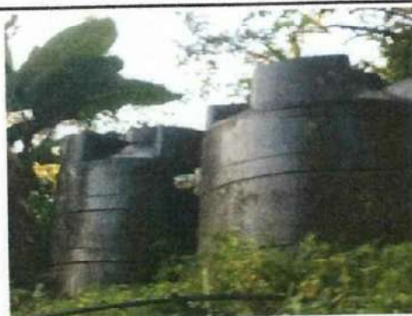
Foto 6: Imagen de tinacos que necesitan ser cambiados debido a que ya no se encuentran en óptimas condiciones.
